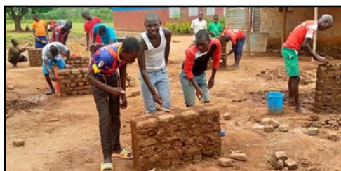
Murstensnedlægnings og betonpraksis
