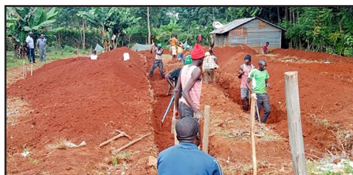
Udgravning af fundamenter
