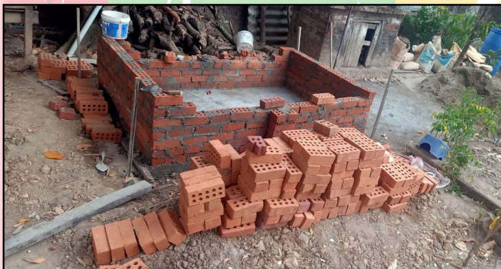
Dåbsbassin ved at blive bygget i Yangon
