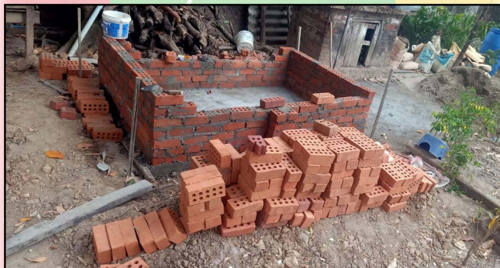
Doopvijver in aanbouw in Yangon
