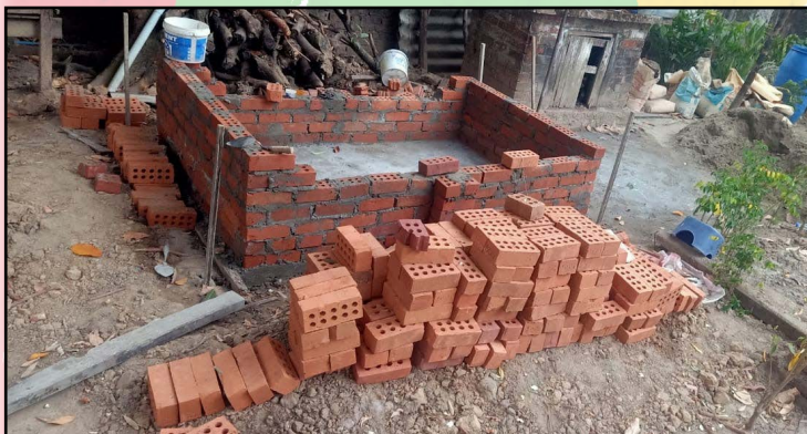
Dåpsbasseng bygges i Yangon
